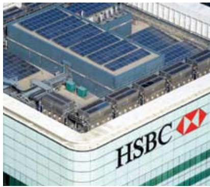
HSBC demuestra su compromiso de apoyar las tecnologías renovables al instalar paneles solares en sus Oficinas Corporativas en Londres.
