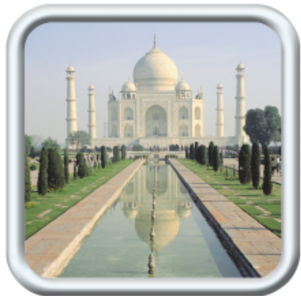
1653 d.c. – Término da construção do Taj Mahal
