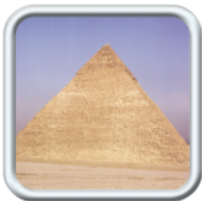
A Grande Pirâmide de Gizé foi concluída em 2570 a.c.
